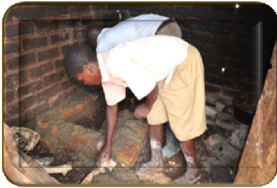
In aanbouw zijnde oven!
